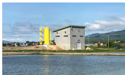
完成した西南揚水機
